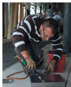
Die Kasette wird zugeschweisst
