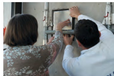
Die Kasette wird eingemauert
