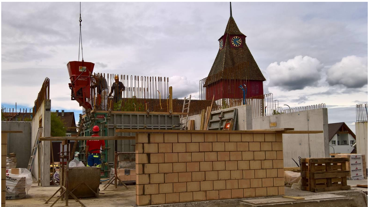
Erneuerung Kirchgemeindehaus Mai 2017
