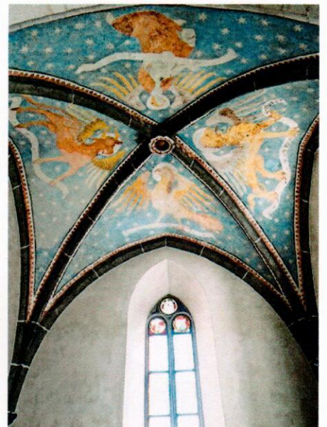
Die Malereien im Chorgewölbe wurden aufwendig restauriert.
